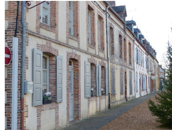
Maison de bourg à 4 travers et deux étages + combles en alignement à La Ferté-Vidame (CdC des Forêts du Perche). (A.F Laboratoire ESO Le Mans., 2017)
