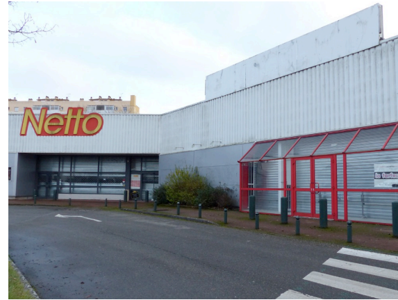
Locaux vacants en zone d'activité, Nogent-le-Rotrou
