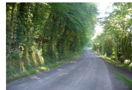
Route de sous-bois, Arcisses Pôle Territorial du Perche, 2016
