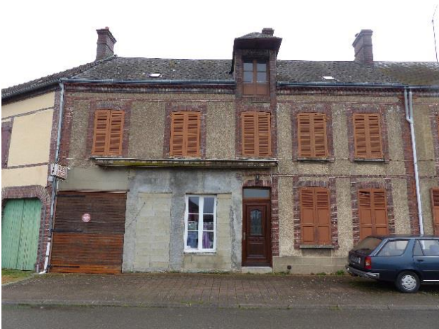
Transformation de commerce en habitation Les Corvées-lès-Yys (CdC Terres de Perche). (A.F Laboratoire ESO Le Mans., 2017)
