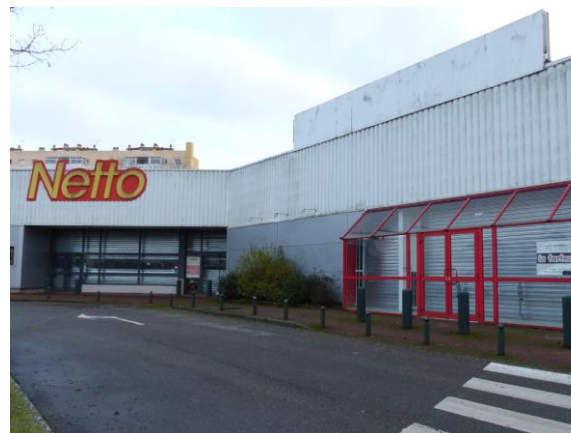
Locaux vacants en zone d'activité, Nogent-le-Rotrou
