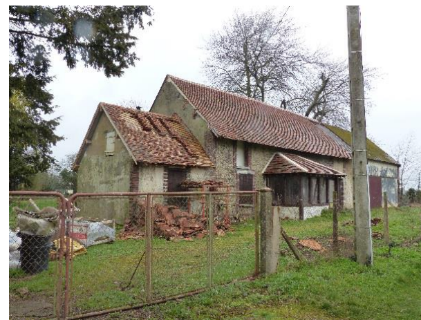
Maison ouvrière avec appentis (situé à gauche) en cours de rénovation à Les Corvées-lès-Yys (CdC Terres de Perche). (A.F Laboratoire ESO Le Mans., 2017)
