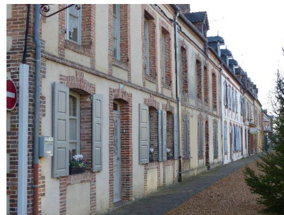
Maison de bourg à 4 travers et deux étages + combles en alignement à La Ferté-Vidame (CdC des Forêts du Perche). (A.F Laboratoire ESO Le Mans., 2017)
