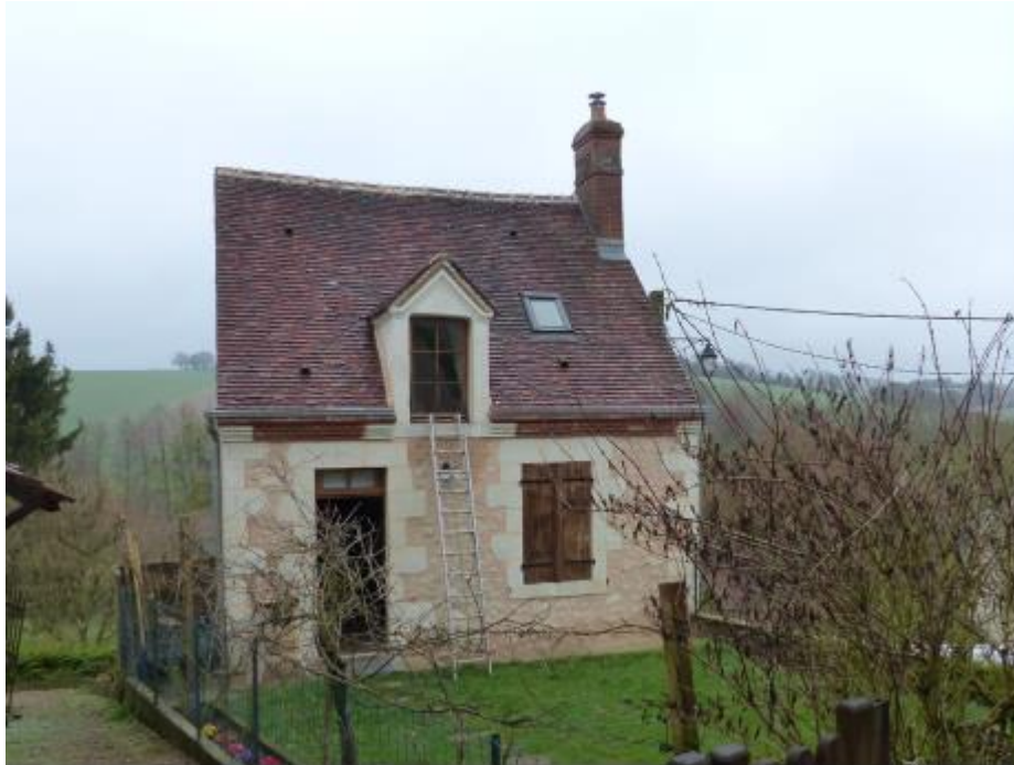
Logement en rénovation, Vichères, Source : ESO, 2017
