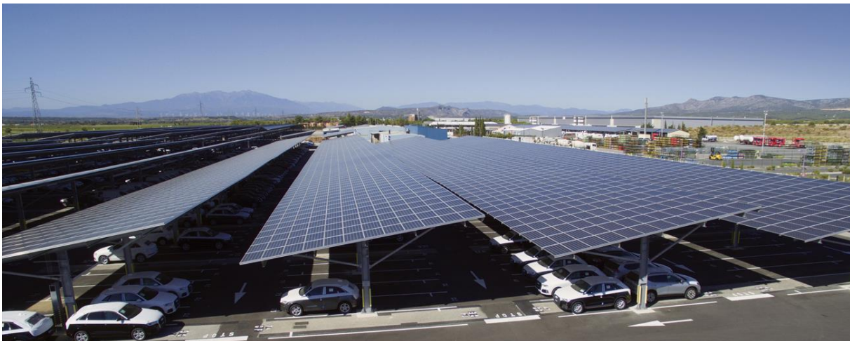
Ombrière photovoltaïque installée au-dessus de places de stationnement Source : Engie
